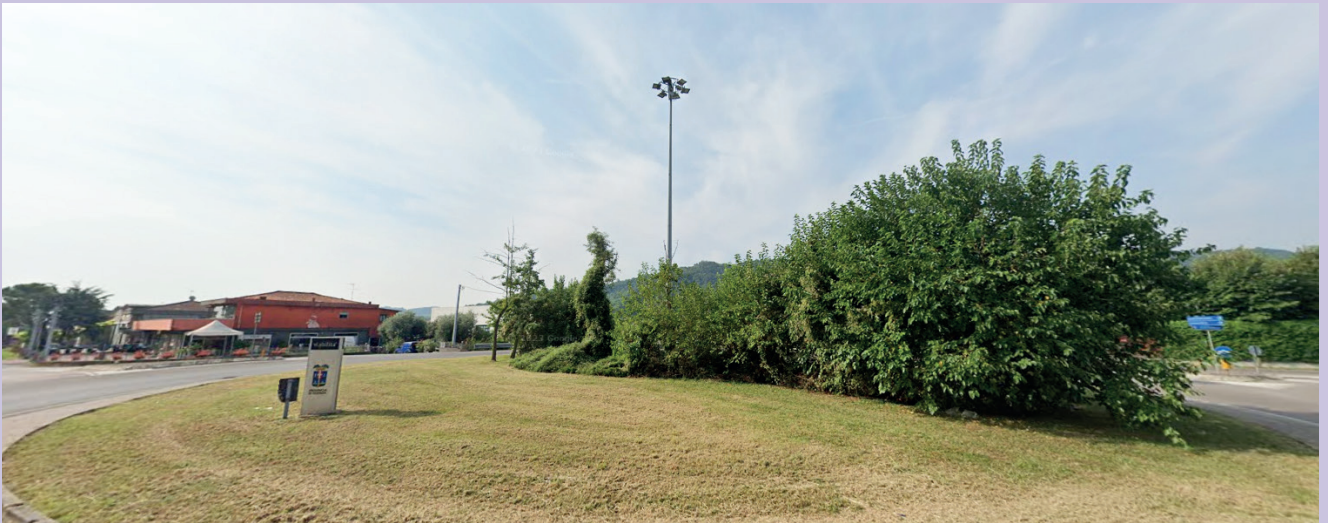
Sostituzione delle luci della torre faro della rotonda lungo la SP Valdichiampo per il risparmio energetico
