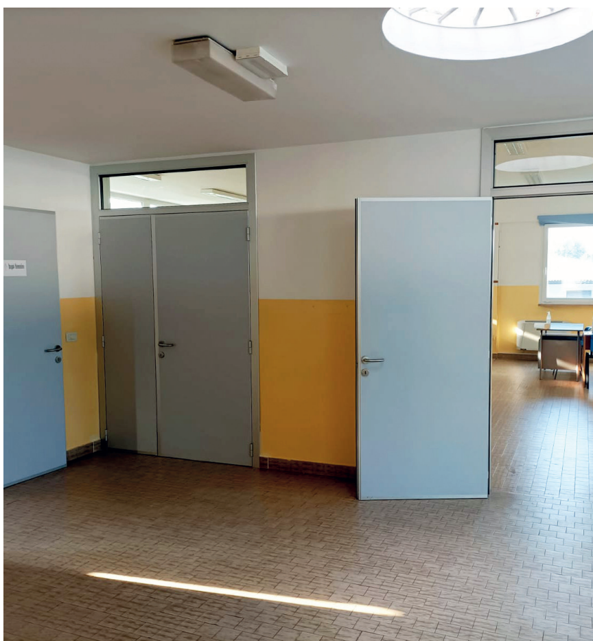
Sostituzione delle porte interne della scuola secondaria di primo grado
