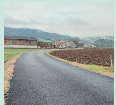
Via Corcironda dopo l'asfaltatura
