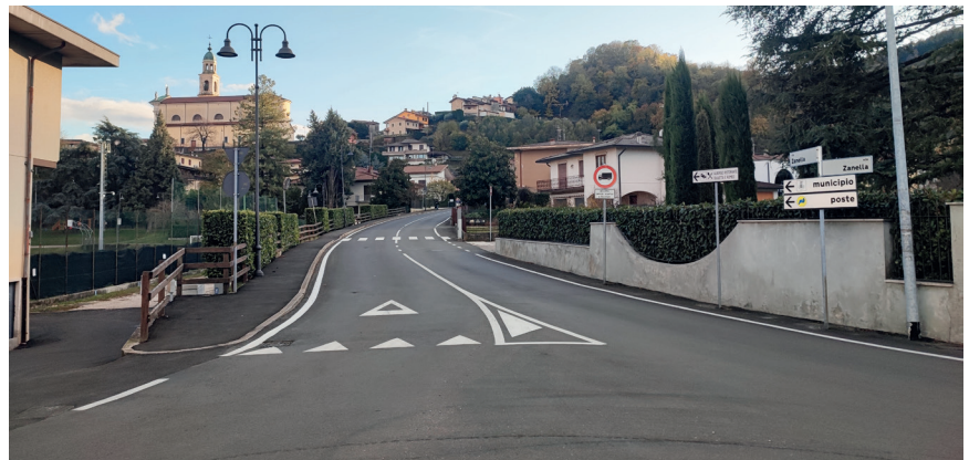
Asfaltatura e segnaletica di via Zanella
