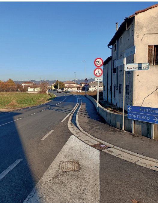
Il nuovo marciapiede lungo la SP Montorsina
